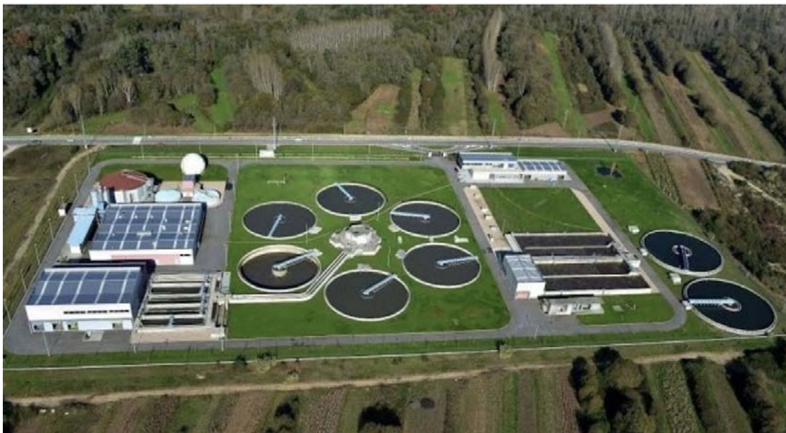
Edar de Guillarei
